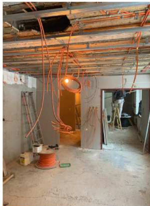
Rekonštrukcia priestorov gynekologicko – pôrodnického oddelenia.
